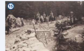
15 Der Bau der Nassfeldstraße im 1. Weltkrieg 1915 - 1916 La costruzione dello strada di Nassfeld durante la Prima Guerra Mondiale Construction of the Nassfeld road during WW I 1915 - 1916
